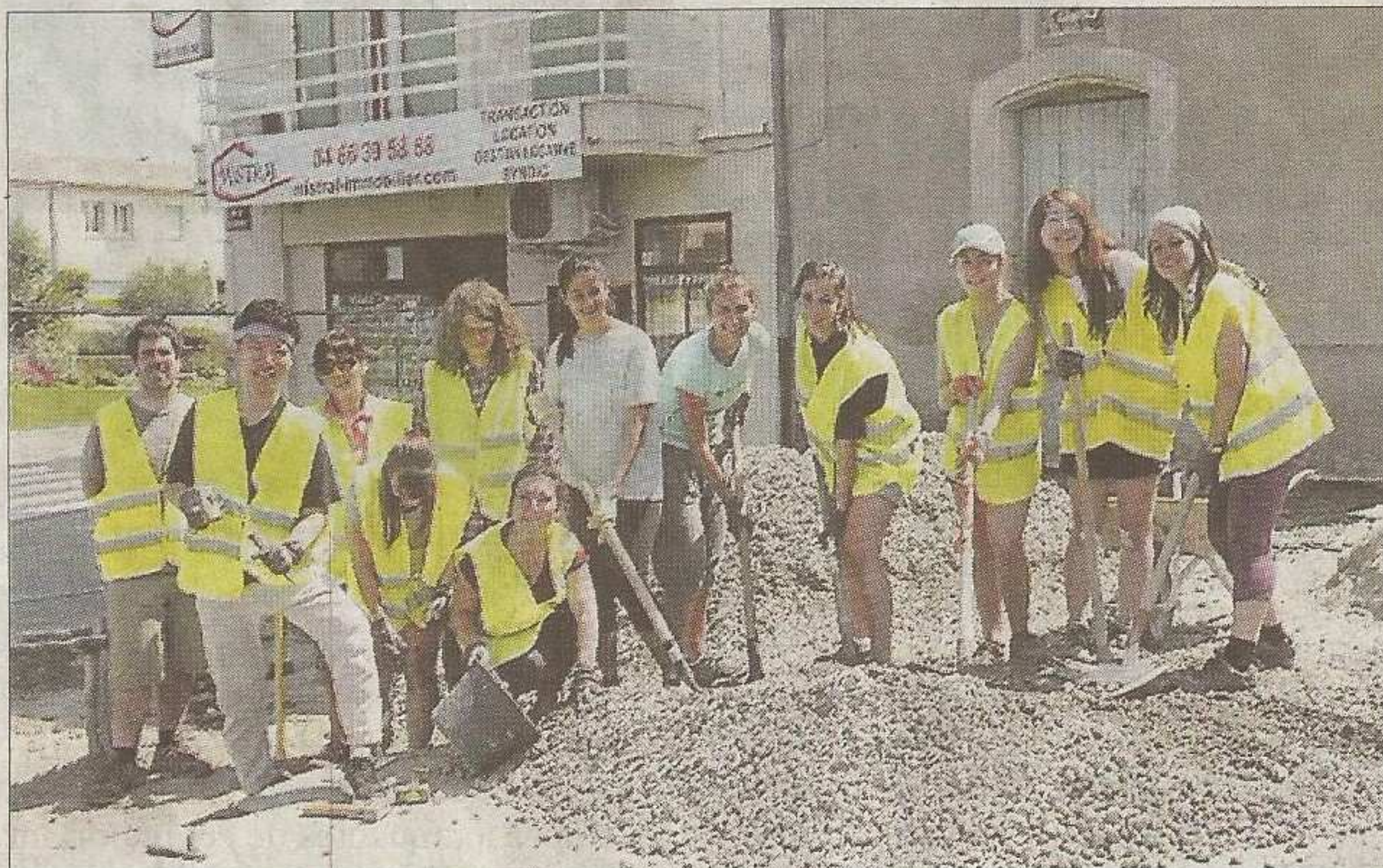
■ Le groupe de jeunes attaque le chantier dans la bonne humeur.
