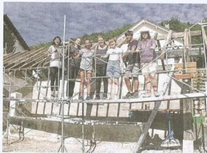
Les jeunes de « Jeunesse et reconstruction » sur le chantier de la fontaine de la Pierre.
