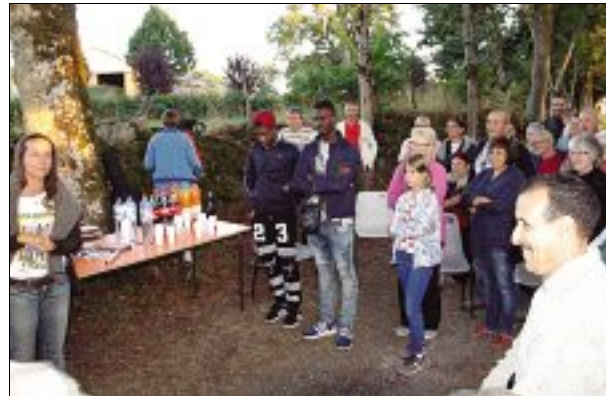
RÉUNIS. Les Pelauds ont été reçus par les maçons du monde pour un moment de convivialité sur le chantier de la Promenade.
