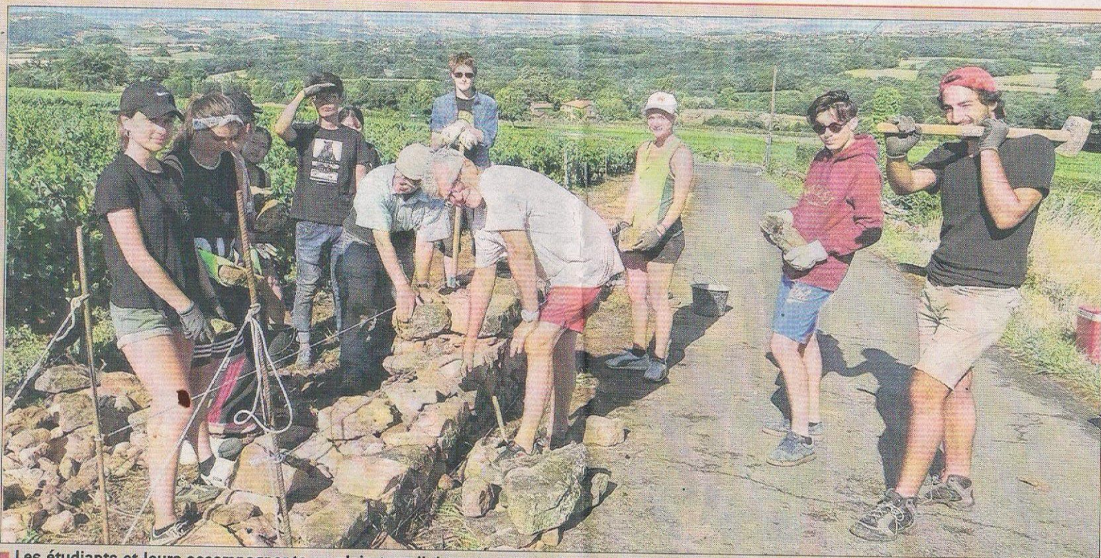
■ Les étudiants et leurs accompagnants en plein travail de restauration d'un mur en pierres sèches. Photo Michel ROBERT
